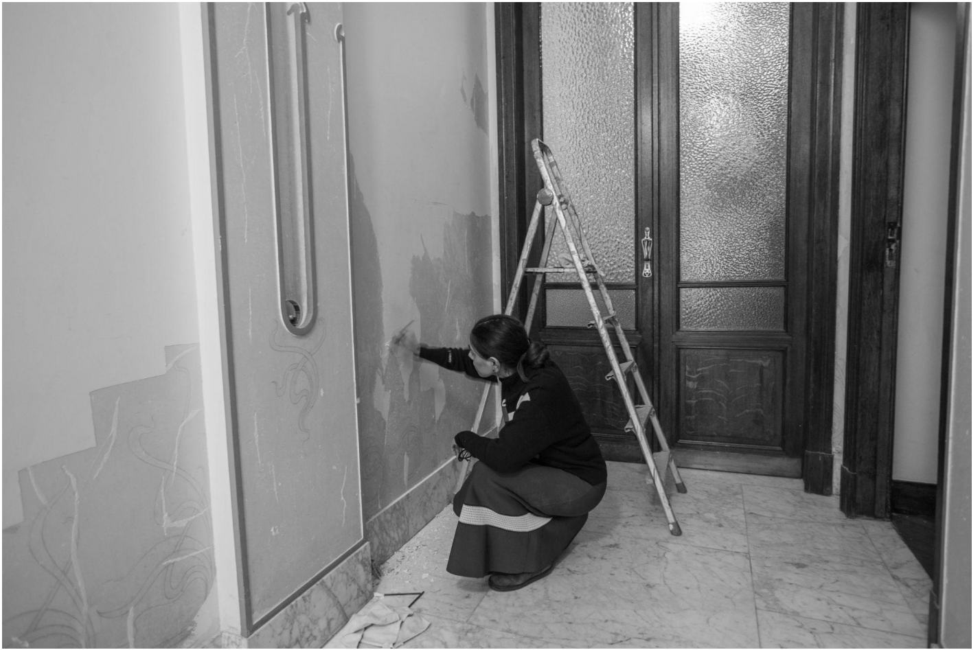
Nupur Tron en train décaper une des multiples couches de peinture dans le hall d'entrée © Fondation Frison Horta
