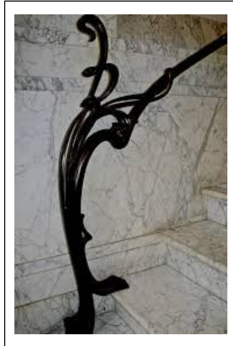
Pilastre de départ de rampe © Fondation Frison Horta
