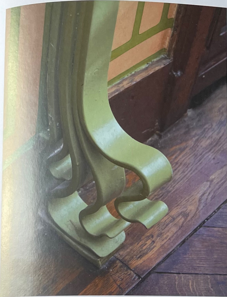
▲ Détail de la structure métallique du jardin d'hiver, 2020 (photo Guy Paulus).
