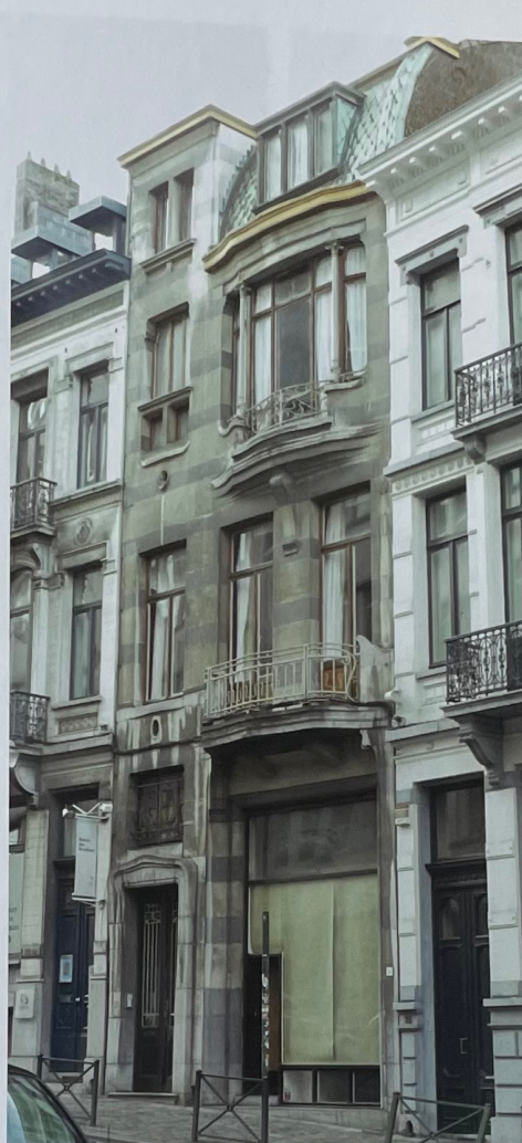
▲ Façade principale actuelle, 2020 (photo Guy Paulus). La façade fut fortement endommagée par des transformations scandaleuses au niveau du rez-de-chaussée, laissant un trou béant qui fera l'objet d'une restauration à venir.
